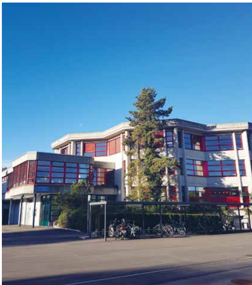
Die Sek Nord ist sanierungsbedürftig.
