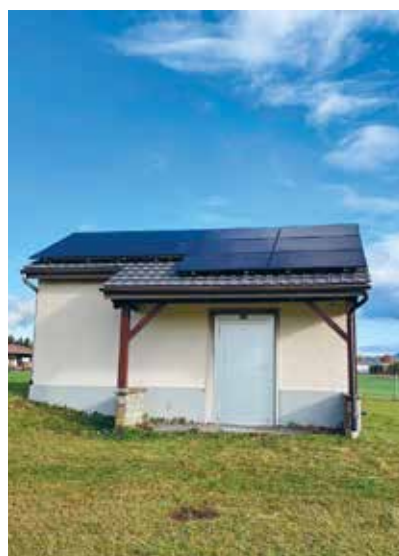
Pumpwerk Ämtwis, Büfelden
