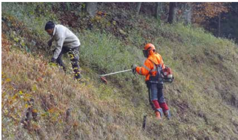
Standfestigkeit war während den Arbeiten am steilen Bord gefragt.
