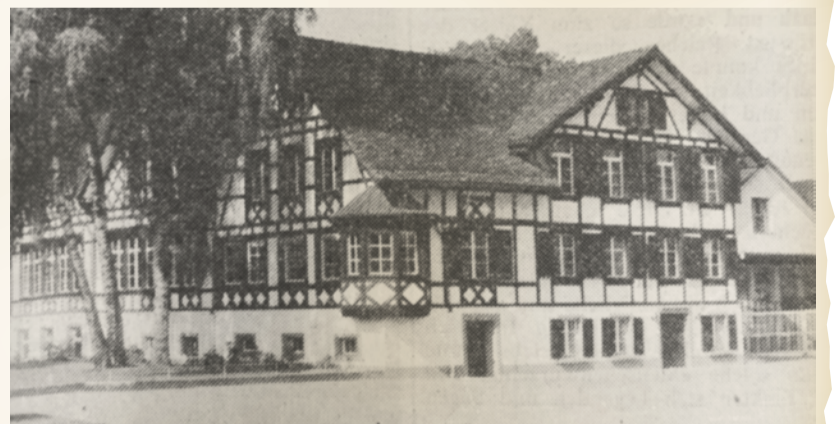
Das Sutter-Kurs-Center im kürzlich renovierten Riegelbau.
