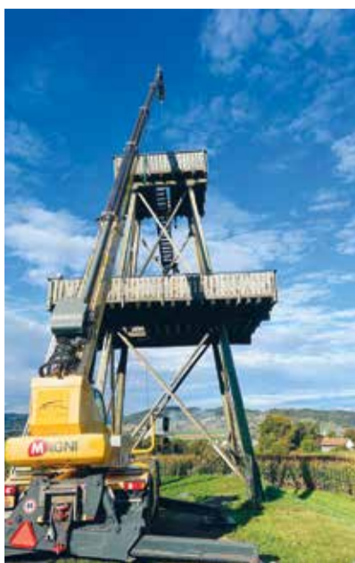
Die Abbauarbeiten am Turm wurden in der vergangenen Woche ausgeführt.
