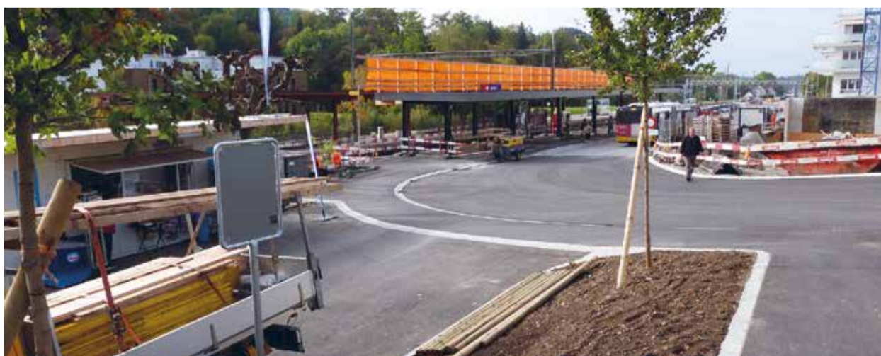
Die Arbeiten am Aadorfer Bahnhof werden bald abgeschlossen sein.
