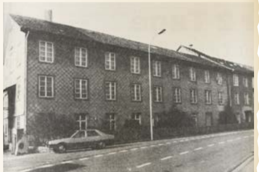
Die Hauptfassade der Weberei soll in ihrer Form erhalten bleiben.
