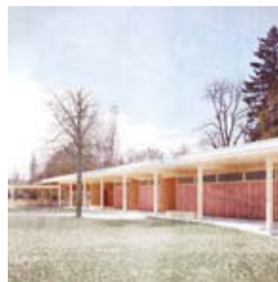
Parkbad an der Murg
