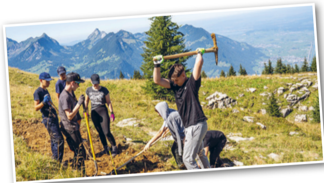
Fundament für eine Kuhtränke.
