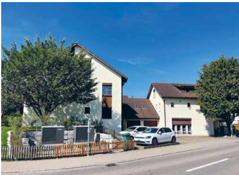
Nach der Beratung die Umsetzung: Neue Fenster und neue Heizung.
