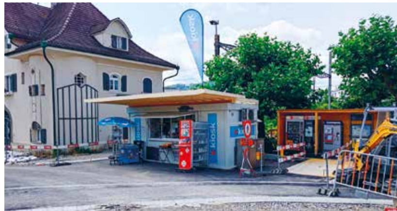
Seit anfangs Juli schützt eine Holzdachkonstruktion das Verkaufslokal des Bahnhofkiosk.
