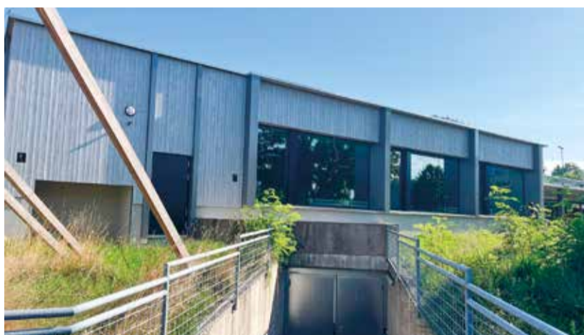
Nach den Umbauarbeiten in den Sommerferien geniessen die Kinder nun ihre Turnstunden in der renovierten Turnhalle.
