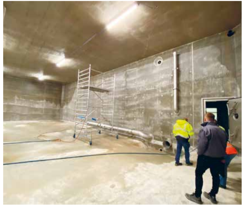
Innenansicht neue Reservoirkammer, Reservoir Buechhalden, Mitte November 2022.
