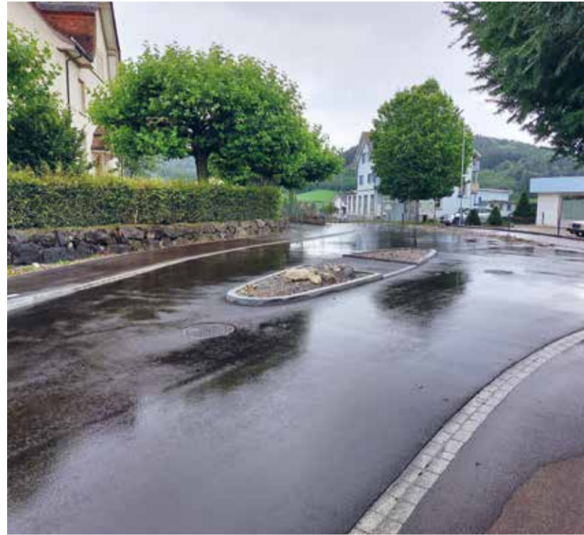
Insel Kreuzung beim Schulhaus Wallenwil.
