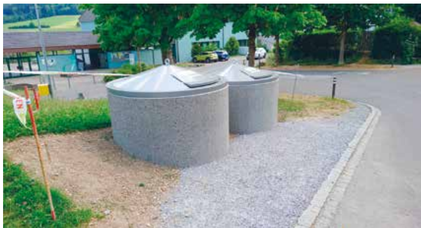
Der Stein des Anstosses – die Abfallentsorgung im Unterflurbehälter beim Schulhaus Ettenhausen.
