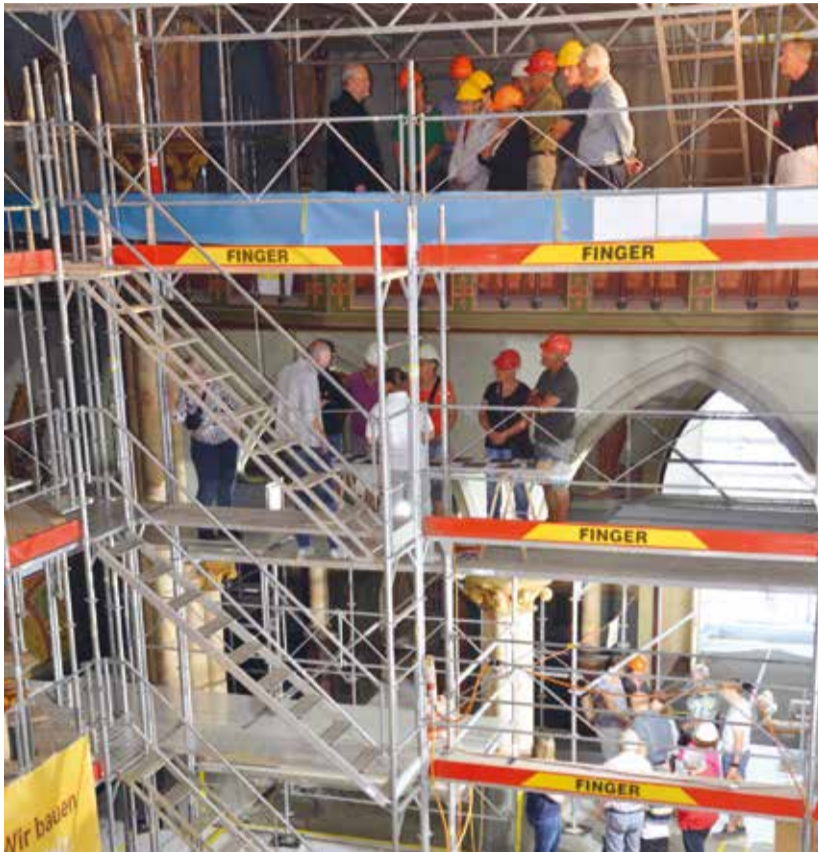
Gross war das Interesse der Besuchenden am Tag der offenen Baustelle.
