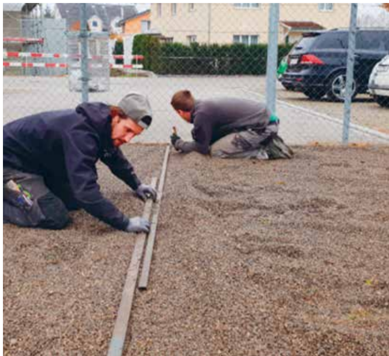
Betonplatten werden von Mitgliedern fachmännisch verlegt.
