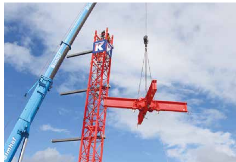
Der Sockel für die Aussichtsplattform wird hochgezogen.
