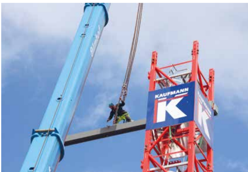
In luftiger Höhe werden die Träger für den Lift eingebaut.
