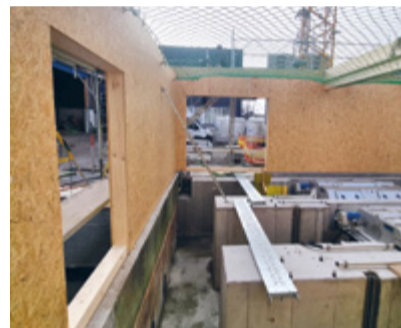
Einblick in den Rohbau
