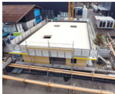
Rohbau der Maschinenhalle.
