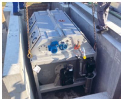
Trommelsiebe zur maschinellen Vorklärung.
