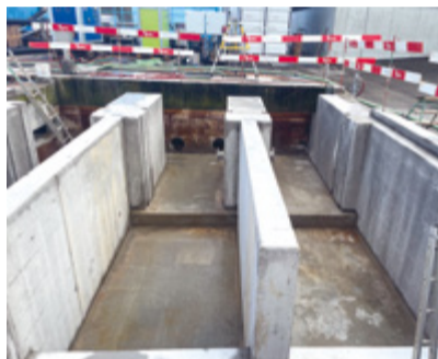
Vorbetonierter Kanal für die Trommelsiebe.
