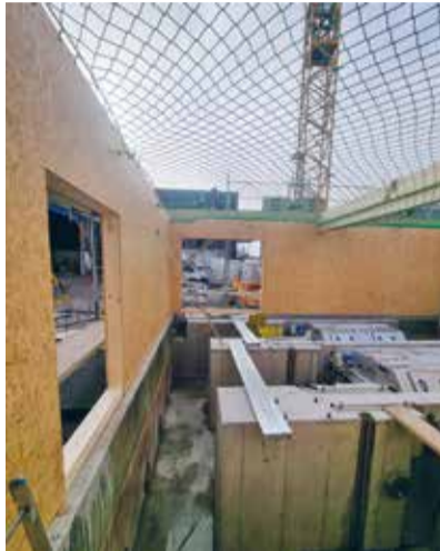
Einblick in den Rohbau der neuen Maschinenhalle.
