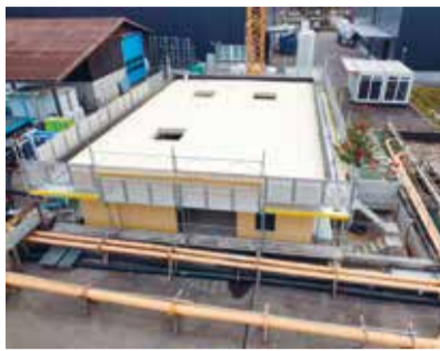
Rohbau der Maschinenhalle.
