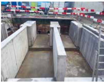
Vorbetonierter Kanal zur Aufnahme der Trommelsiebe.
