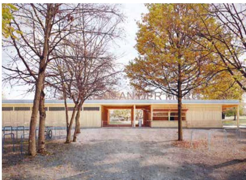
Der Eingangsbereich des Holzbaus mit Kasse und Gastronomie rechts und Technik links.
